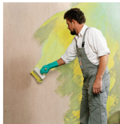
PCI Wadian, tynn, grønnfarget membrandispersjon med høy damptetthet, påføres i 2 lag.
