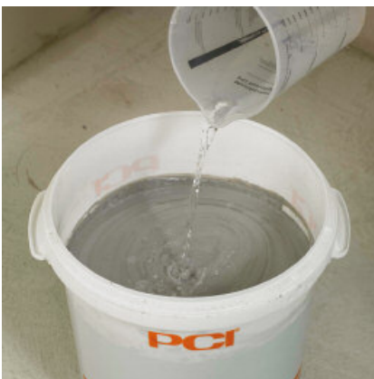
Til påføring med kost (1b) tilsettes nødvendig mengde vann.
