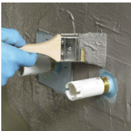
Tetningsmansjetter PCI Pecitape 10 x 10 monteres forskriftsmessig.
