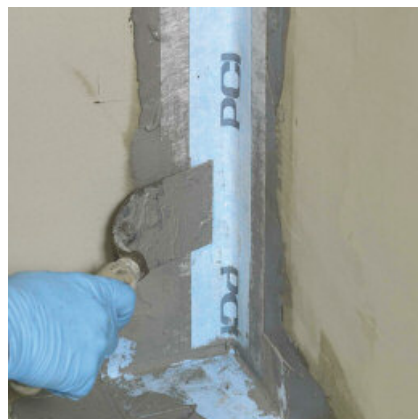
Tetningsbånd PCI Pecitape legges inn i hjørnene.
