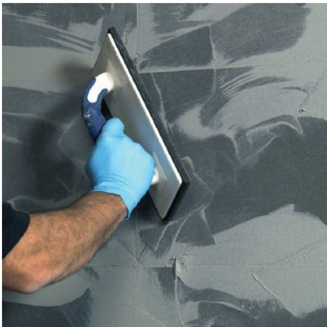
Smidig og enkel fugging, kan brukes i ca. 40 minutter.
