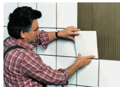
Sikker montering av fliser med PCI FT Klebemörtel flislim
