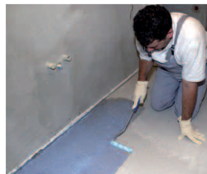
PCI Gisogrund beskytter sugende underlag mot skadelig fuktpåvirkning og på grunn av forsterkning av overflaten blir bæreevnen og vedheften forbedret.
