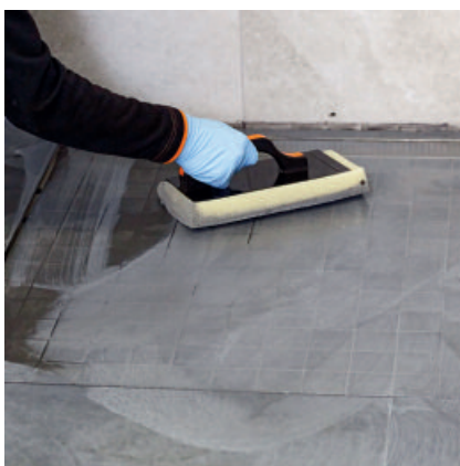
Etter ca. 10-45 minutter kan den fugede flaten emulgeres med et svampbrett og vaskes ren.
