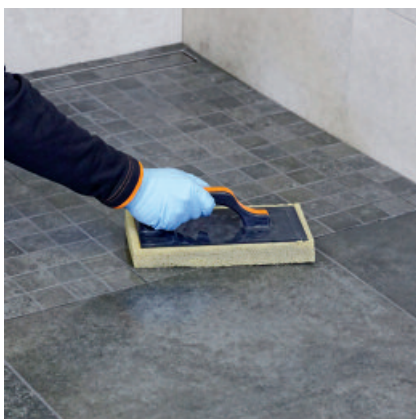
Deretter brukes svampbrettet til å fjerne restsløret og vaske overflaten ren.
