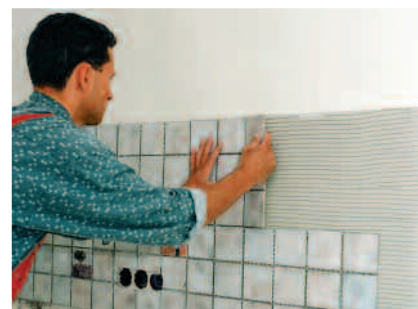
Flisene siger ikke, og posisjonen kan justeres i en viss tid før flisene sitter fast.
